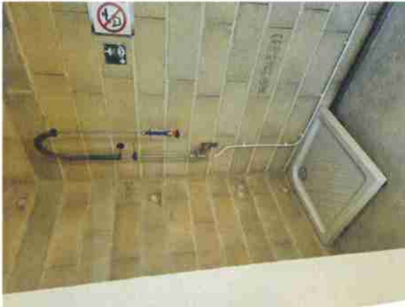
Potence simple de remplissage, trappe d'accès automatisée, égouttoir pour rince bidon en inox
