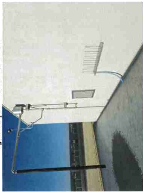
Potence simple de remplissage, trappe d'accès automatisée, égouttoir pour rince bidon en inox
