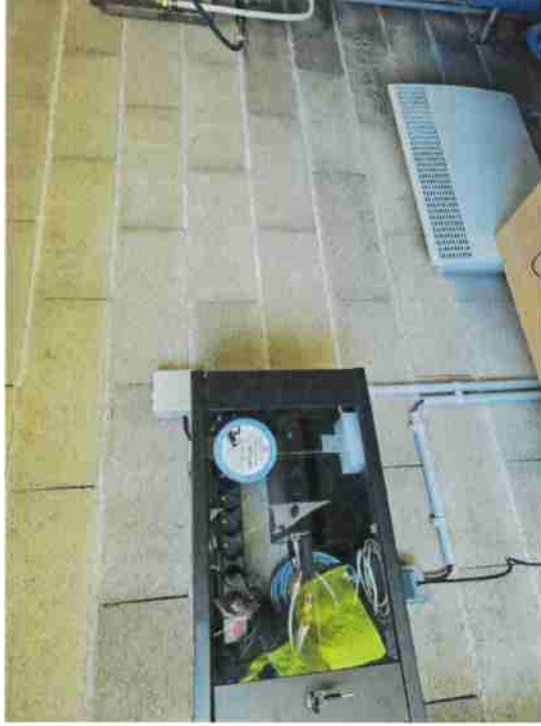
Vanne, débitmètre, ventouse et réducteur/stabilisateur
