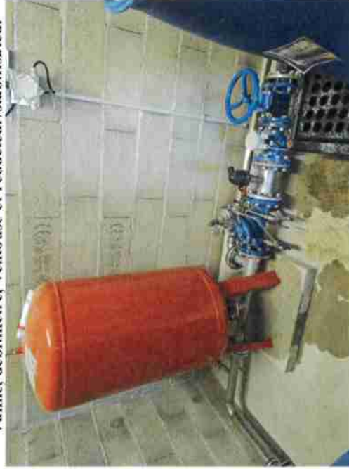
Vanne, débitmètre, ventouse et réducteur/stabilisateur
