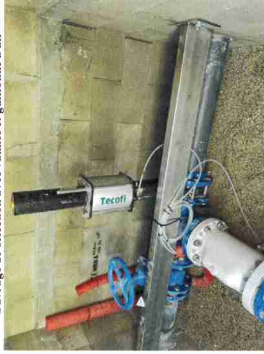
Ouvrage de sélection avec vannes et guillotine à air
