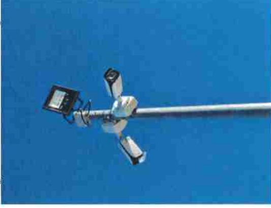
Eclairage LED et caméras infra rouge sur mât
