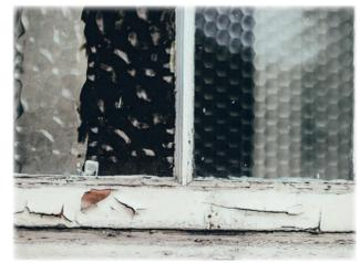
Infiltrations d'air par les ouvertures
