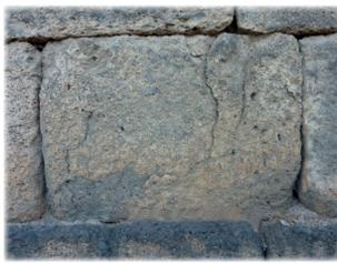
Sources d'infiltrations d'air par les joints et les fissures
