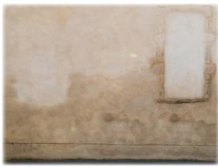
Emploi de matériaux non adaptés bloquant l'humidité au niveau du soubassement de la maison
