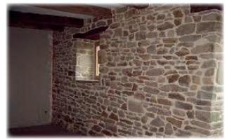
L'épaisseur de la maçonnerie est un atout pour le confort thermique.
