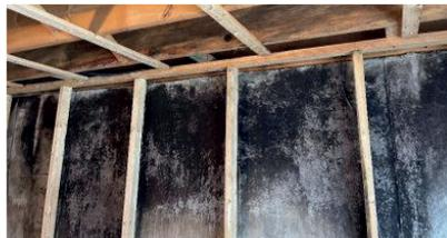
Formation de condensation sur un mur isolé avec de la laine de verre.
