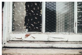
*Infiltrations d'air par les ouvertures*
