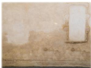
*Emploi de matériaux non adaptés, bloquant l'humidité au niveau du soubassement*
