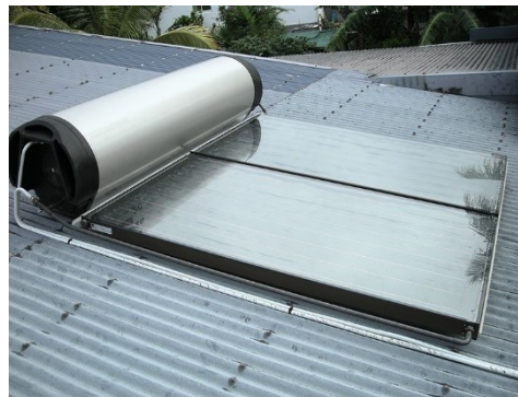
Figure 55 : Capteur solaire thermique installé en toiture
