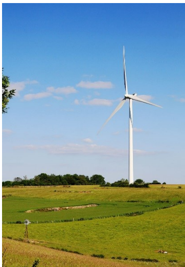
Figure 50 : Exemple d'éolienne à axe horizontal
