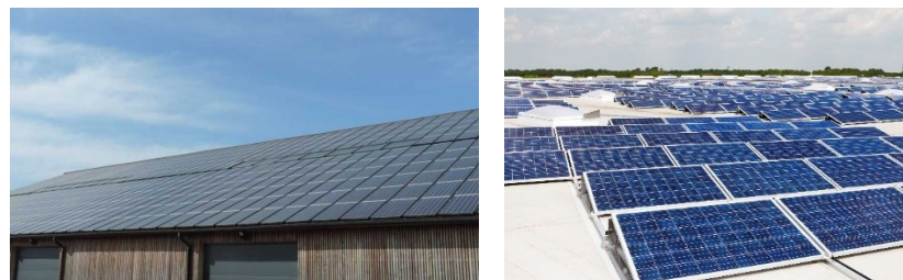
Figure 41 : Panneaux PV en surimposition à gauche et intégrés en toiture à droite
