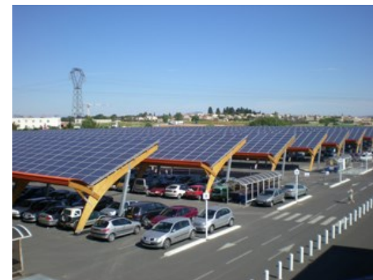
Figure 42 : Ombrières photovoltaïques à St Aunès (Hérault). Crédit photo : SUNVIE
