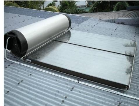
Figure 55 : Capteur solaire thermique installé en toiture
