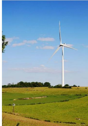
Figure 50 : Exemple d'éolienne à axe horizontal
